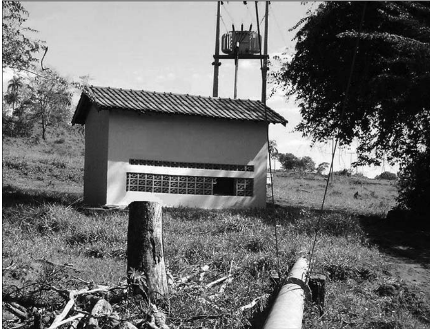
Figura 68. Instalação do conjunto motobomba.
